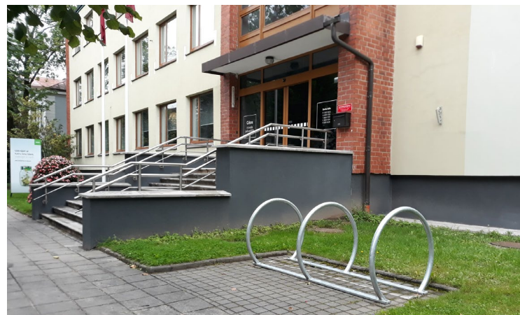
Energoefektivitātes pasākumu ieviešana Raunas ielā 4
