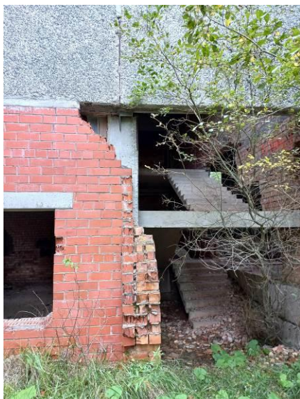
Būves (kad.apz. 4211 005 0300 001) konstrukcijas
