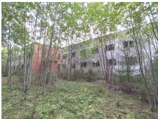
Būves (kad.apz.4211 005 0300 001) konstrukcijas
