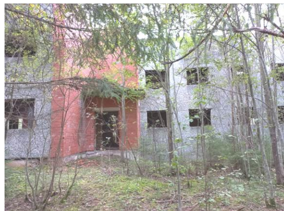
Būves (kad.apz. 4211 005 0300 001) konstrukcijas
