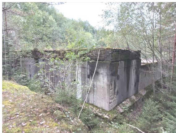
Būves (kad.apz.4211 005 0300 002) konstrukcijas
