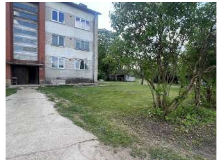
Dzīvojamās ēkas fasādes daļa
