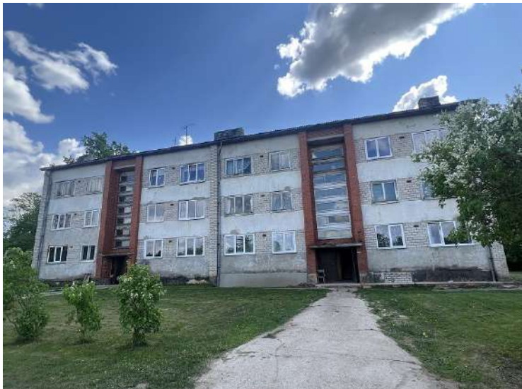
Dzīvojamās ēkas fasādes daļa
